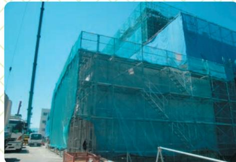
暖冬のおかげで大雪等もなく、工程どおり順調にコンクリート工事、鉄筋工事、型枠工事等を行っております。建築工事は3階から4階にかけてのコンクリート打設、4階から5階の柱配筋・型枠工事を行っています。電気・機械設備工事においては、引き続き、壁・梁・床スリーブ、ピット内衛生配管工事・天井内機器吊込・配管・ダクト工事等を行っております。
